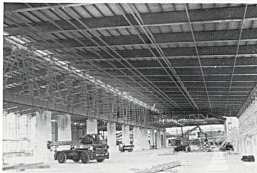
Reifehalle in der Rekonstruktionsphase
