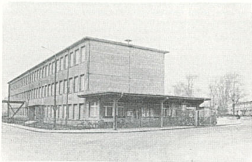
Werkseingang mit Sozialgebäude
